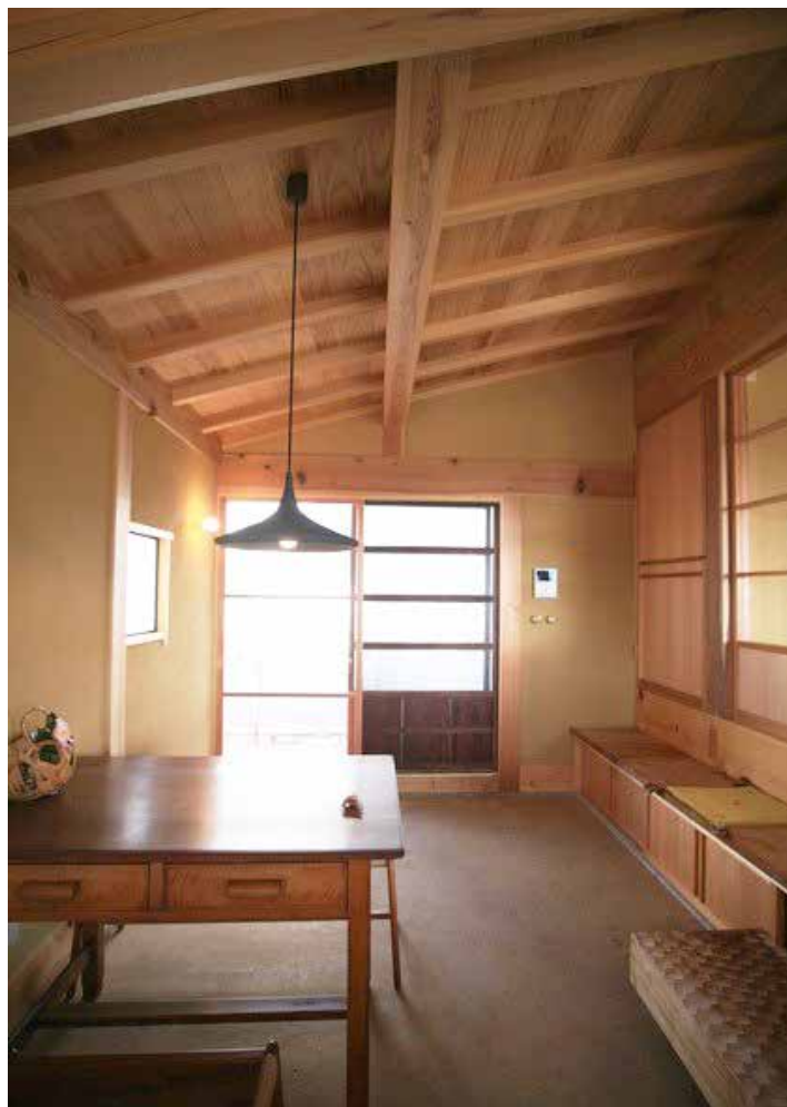
住宅における杉無垢構面板の現し採用工法事例 野の草設計室「松山の家」 ※勾配天井で使用の場合は床倍率に関して公的機関とのすり合わせが必要になる場合がございます。
