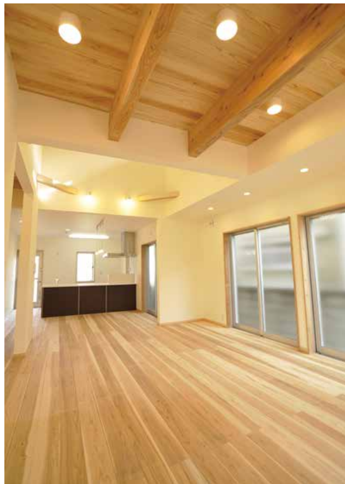
住宅の2階床に階下からの現し工法で採用した事例
